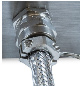
Figure A-47 : Câble et presse-étoupe installés dans l'enceinte
