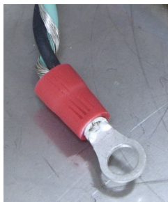
Figure A-53 : Terminaison du câble de masse
