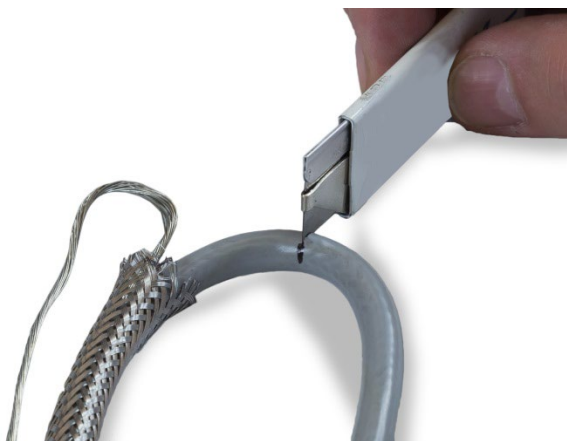
Figure A-33 : Découpe autour de la gaine du câble
